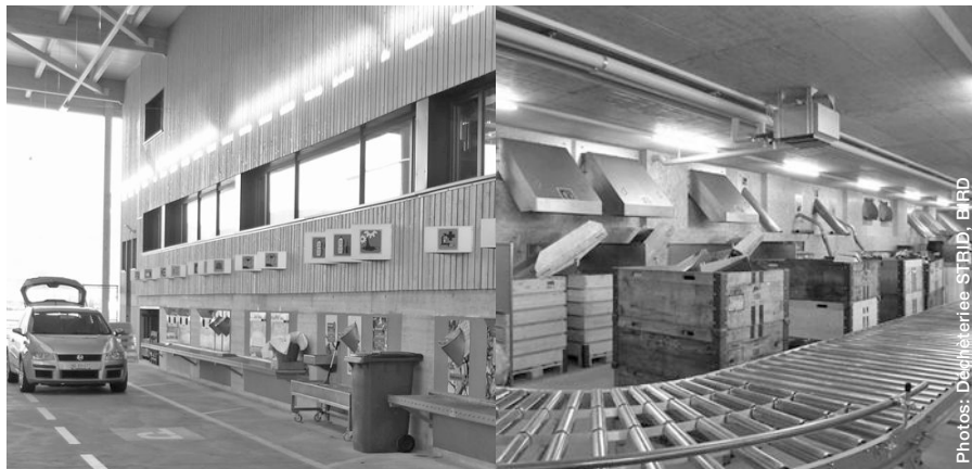
La nouvelle déchèterie pour particuliers de la STRID à Yverdon-les-Bains est innovante pour limiter les reprises sauvages. Les petits déchets recyclables sont insérés à l'intérieur d'ouvertures dans le mur (à gauche) et atterrissent au sous-sol dans des conteneurs appropriés (à droite).
