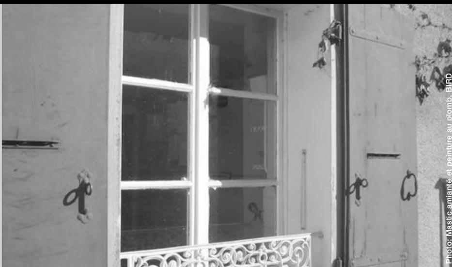
Photo: Mastic amiante et peinture au plomb, BIRD
