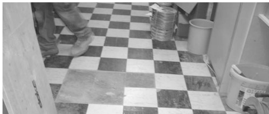
*Les rapports d'expertise permettent de repérer les matériaux amiantés (ici dalettes en vinyle) menaçant la santé des ouvriers de la construction mais aussi celle des particuliers effectuant des travaux eux-mêmes, voire celle des utilisateurs. Lors de mise à l'enquête, ils doivent être contrôlés par les communes avec, comme grille de lecture, le cahier des charges de l'ASCA.*
