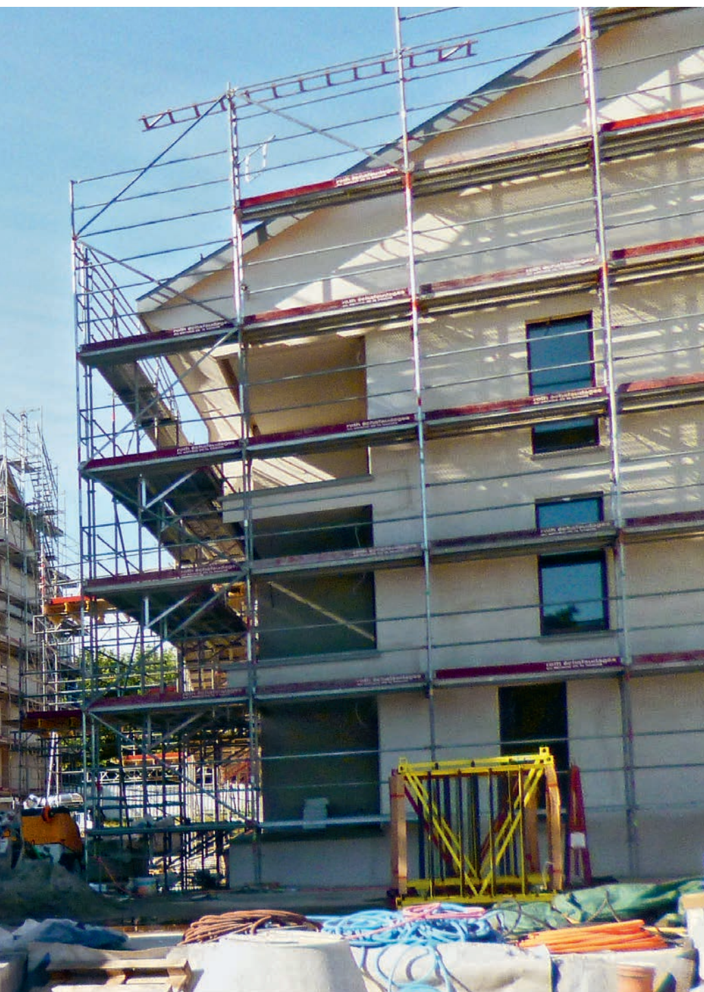
Une déchèterie de chantier permet de trier entre 15 et 20 catégories de déchets distincts. Bennes, conteneurs, sacs de recyclage, installés de manière permanente ou ponctuelle, facilitent le travail des ouvriers. Une formation initiale et un panneau récapitulatif (photo) permettent d'éviter les mélanges de déchets.
