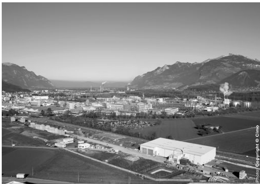
Au premier plan, la halle de décontamination de l'ancienne décharge industrielle du Pont Rouge (site chimique de Monthey).
